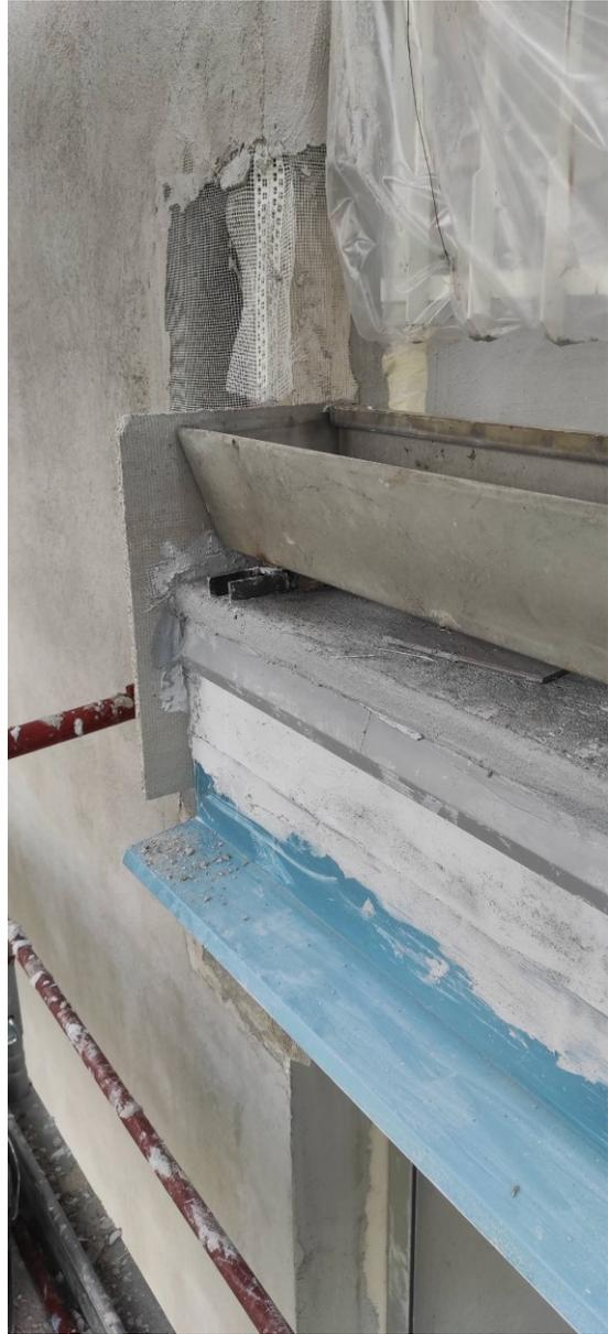
Si chiede di fissare correttamente la scossalina alla soletta, in quanto in alcuni punti non è bene adesa e possono verificarsi infiltrazioni
